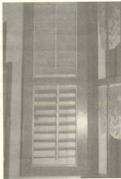
ภาพหน้าต่างบานเกล็ดไม้ปรับได้ แกนไม้ตรงกลางใช้ปรับเปิดปิดหน้าต่างได้
