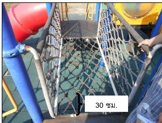
ภาพประกอบ 8 อุปกรณ์เป็นปายซึ่งเป็นสะพานเชือกเพื่อเดินข้ามลักษณะเป็นเชือกที่ถักทำเป็นตาข่าย ช่องของตาข่ายมีขนาดใหญ่เกินกว่าเกณฑ์มาตรฐานข้อกำหนดด้านความปลอดภัยของสนามเด็กเล่นสำหรับเด็กก่อนวัยเรียน
