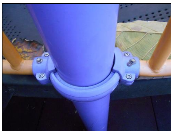
ภาพประกอบ 11 นอต-สกรู เป็นระบบกันคลาย ซึ่งเป็นไปตามเกณฑ์มาตรฐานข้อกำหนดด้านความปลอดภัยของสนามเด็กเล่นสำหรับเด็ก
