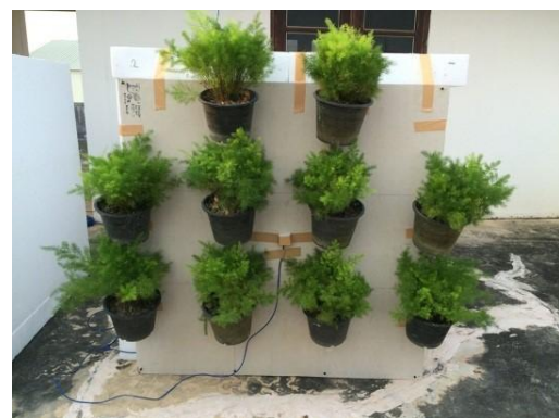
ภาพที่ 4 การติดตั้งสวนแนวตั้งสำหรับการทดลอง
