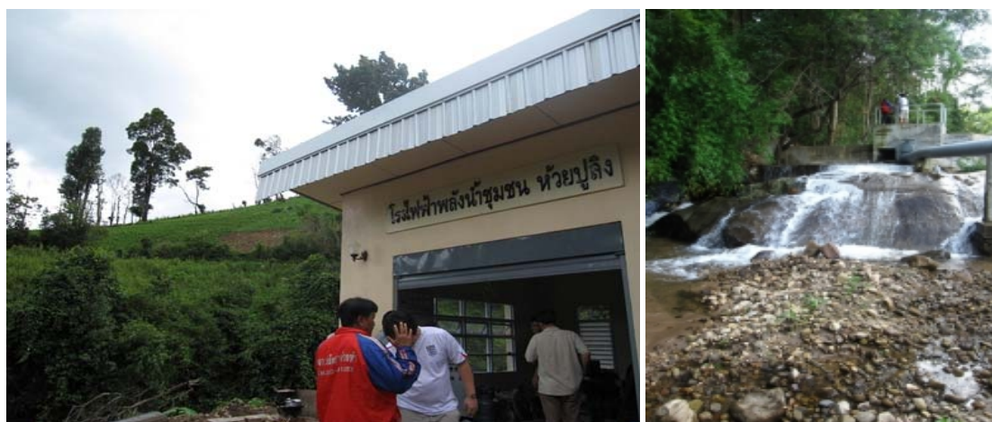
รูปที่ 7. โรงไฟฟ้าพลังงานน้ำขนาดเล็ก
