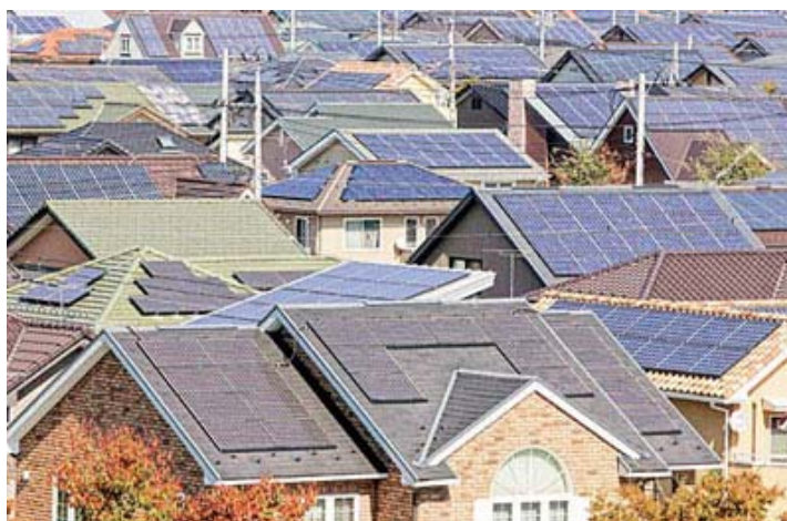
รูปที่ 6. ที่อยู่อาศัยที่ติดตั้งเซลล์แสงอาทิตย์สำหรับผลิตไฟฟ้าบนหลังคา
