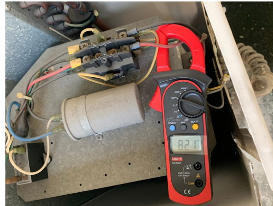
ภาพประกอบ 8 เครื่องปรับอากาศที่ไม่ได้ติดตั้งอุปกรณ์ระบายความร้อนจากน้ำทิ้งของพัดลมคอยล์เย็น
