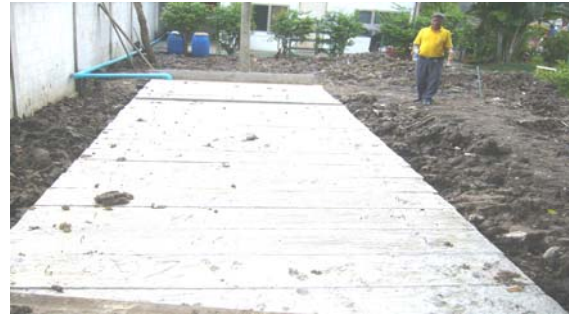
ภาพประกอบ 7 แสดงระบบบำบัดน้ำเสียที่สร้างเสร็จปิดฝา ระบบด้วยแผ่นคอนกรีตสำเร็จ
