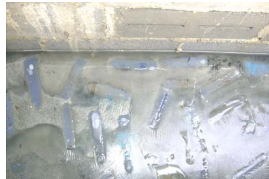
ภาพประกอบ 8 แสดงตัวกลางจากขวดพลาสติกที่นำมาใส่ในระบบบำบัดน้ำเสียพร้อมทั้งใส่หัวเชื้อจุลินทรีย์ที่ผู้วิจัยพัฒนาขึ้นเพื่อทำการ Start up ระบบบำบัดให้มีประสิทธิภาพสูงสุด
