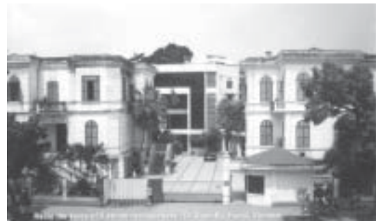
สำนักงานใหญ่ สถานีวิทยุกระจายเสียงเวียดนาม กรุงฮานอย เลขที่ 58 ถนนกว๋านสือ (Quan Su) กรุงฮานอย ประเทศสาธารณรัฐสังคมนิยมเวียดนาม
