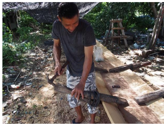
ภาพที่ 10 การติดตั้งแผ่นกระดานโดยใช้อุปกรณ์หนีบจับแผ่นไม้กระดาน ที่มา : ภาพถ่ายโดยผู้วิจัย เมื่อวันที่ 24 มิถุนายน 2558
