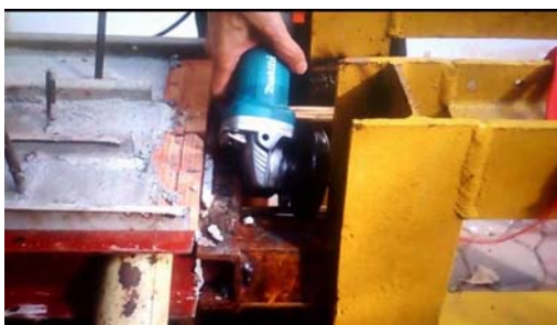
รูปที่ 16 ตัดไม้ไผ่บิดเกลียวออกจากแท่นยึด
