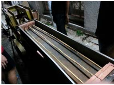
รูปที่ 14 การวางไม้ไผ่เสริมและดึงบิดเกลียว
