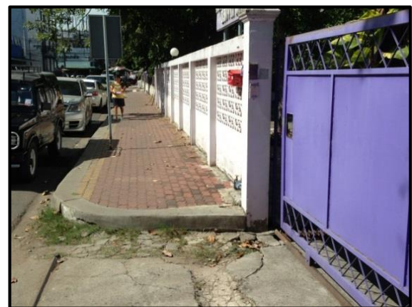
รูปที่ 31 ทางเท้าไม่มีทางลาดเชื่อมกับถนน
