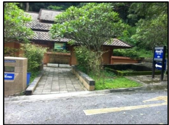
รูปที่ 3 ทางเข้าห้องส้วมที่มีรางระบายน้ำ ซึ่งเป็นอุปสรรคต่อการเข้าถึงห้องส้วมของผู้ใช้วีลแชร์
