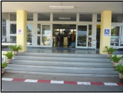
รูปที่ 25 บันไดที่ศูนย์ราชการจังหวัดนครนายกไม่มีสิ่งอำนวยความสะดวกต่อผู้สูงอายุและผู้พิการทางสายตา
