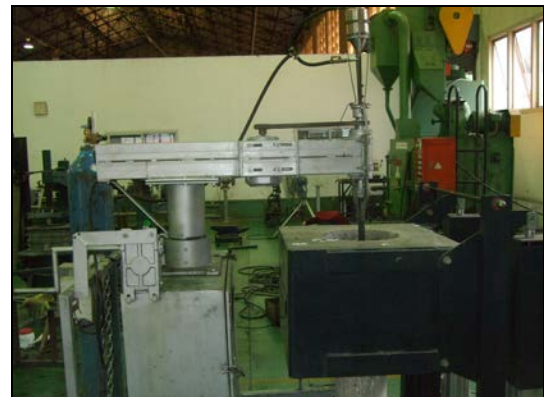
รูปที่ 1 เครื่องกำจัดแก๊สไฮโดรเจนเคลื่อนที่พร้อมอุปกรณ์ฉีดผง
