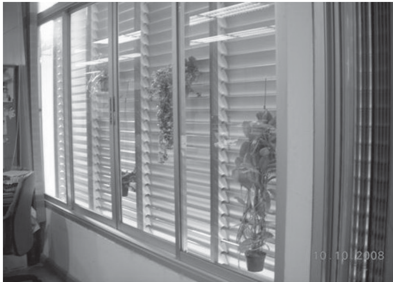
ภาพที่ 11 แสดงช่องเปิดกระจกของห้องสมุดหลังการติดตั้งอุปกรณ์บังแดด (วันที่ 10 ตุลาคม พ.ศ. 2551)
