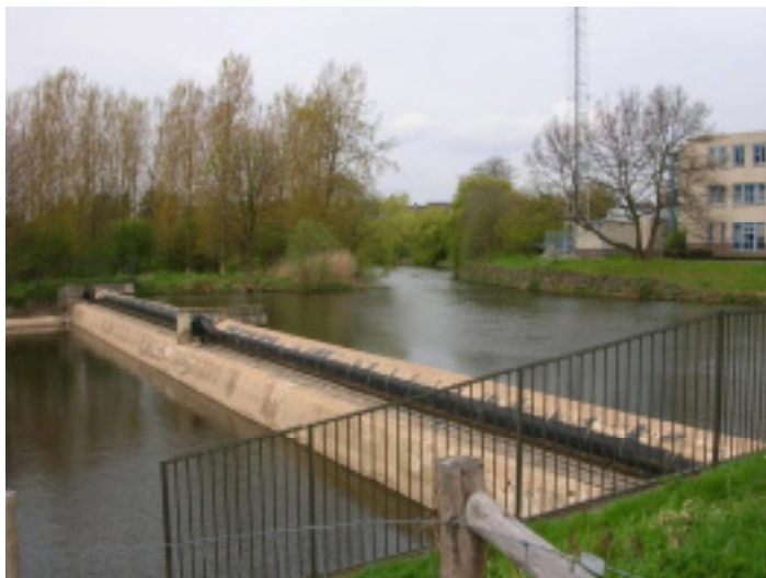
ภาพที่ 4 ฝ่ายกั้นน้ำแบบบั้งลม
