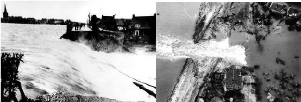
ภาพที่ 6 กำแพงป้องกันน้ำถูกน้ำกัดเซาะพังทลาย
