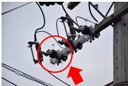
ภาพที่ 6 การติดตั้งลูกถ้วย TR-202 พร้อม Barrier
