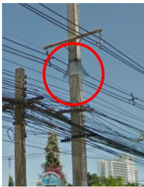
ภาพที่ 5 การติดตั้งตาข่ายกันงู (Snake Guard)
