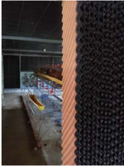
ภาพที่ 4 การติดตั้งพัดลมดูดอากาศและแผงรังผึ้งควบคุมอุณหภูมิความชื้นในฟาร์มไก่ไข่
