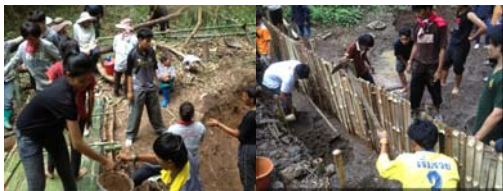
ภาพที่ 1 นิสิตและชาวบ้านร่วมกันสร้างฝายชะลอน้ำในชุมชน โดยใช้วัสดุจากท้องถิ่น
