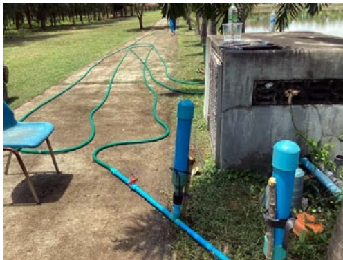
ภาพที่ 2 การต่อสายยางจากส่วนติดตั้งท่อแอร์แวกไปยังส่วนรองรับน้ำ
