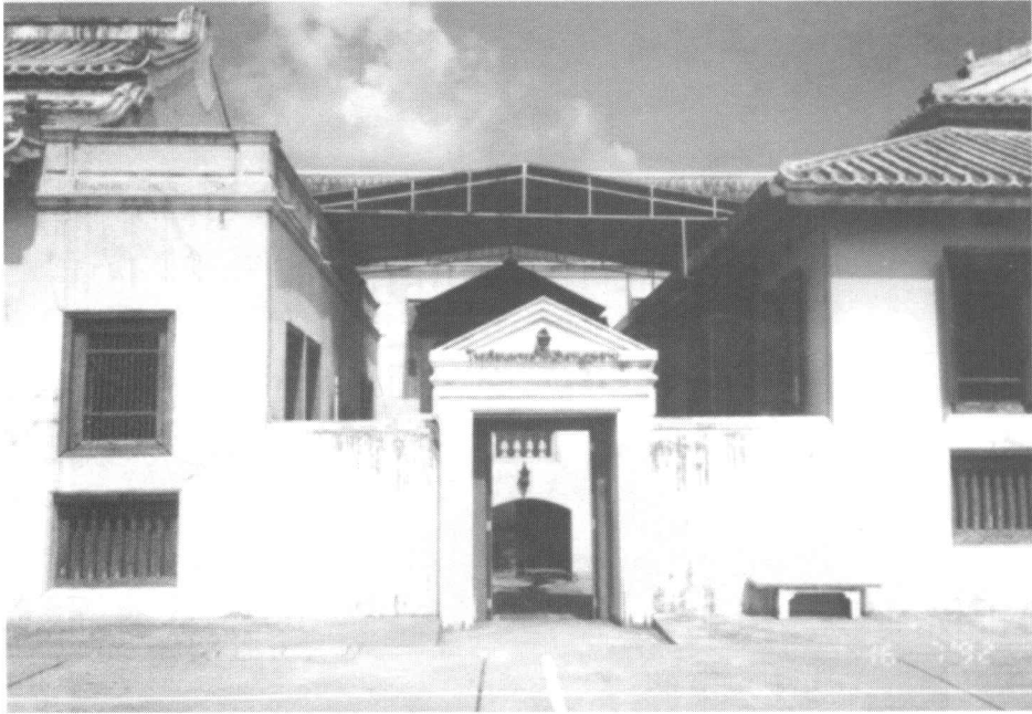
โรงเรียนพระตำหนักสวนกุหลาบ (ยุคใหม่) ตั้งอยู่ในพระบรมมหาราชวัง
