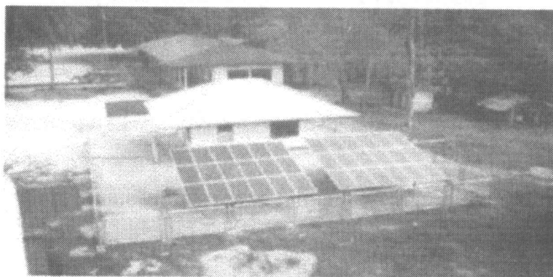
รูปที่ 13 ระบบผลิตไฟฟ้าด้วยเซลล์แสงอาทิตย์สำหรับโรงเรียนชนบทที่ไม่มีไฟฟ้า
